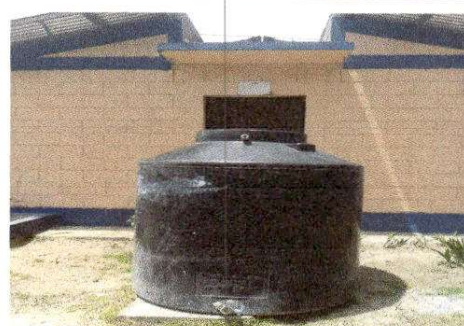
Foto 6: Sustitución de depósito de agua de 1000L
