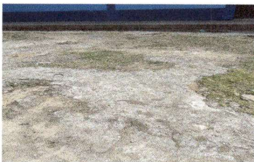
Foto 5: Sustitución de piso de torta de concreto
