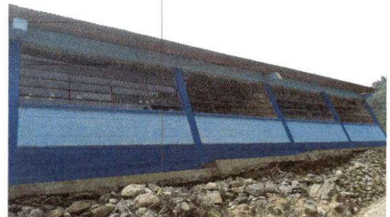
Foto 4: colocación balcones de metal
