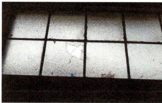
Foto 3: Sustitución de vidrios en ventanas
